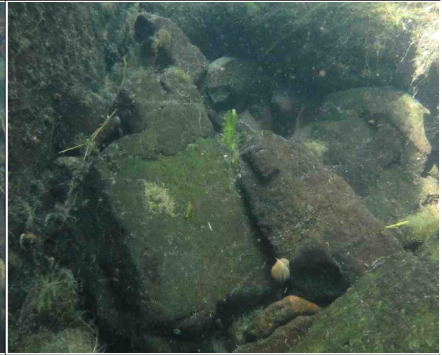
P3하행 교각 보호사석, 상태 양호
