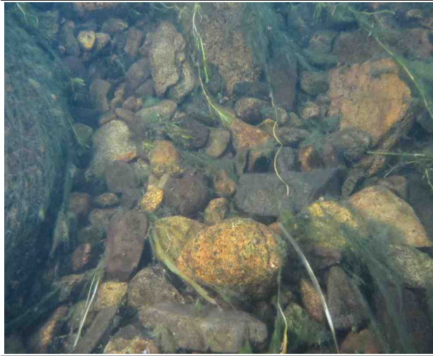
P3하행 교각 보호사석, 상태 양호
