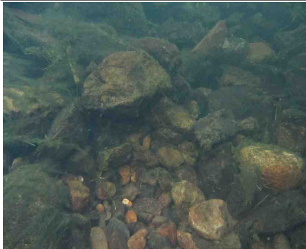
P3하행 교각 보호사석, 상태 양호
