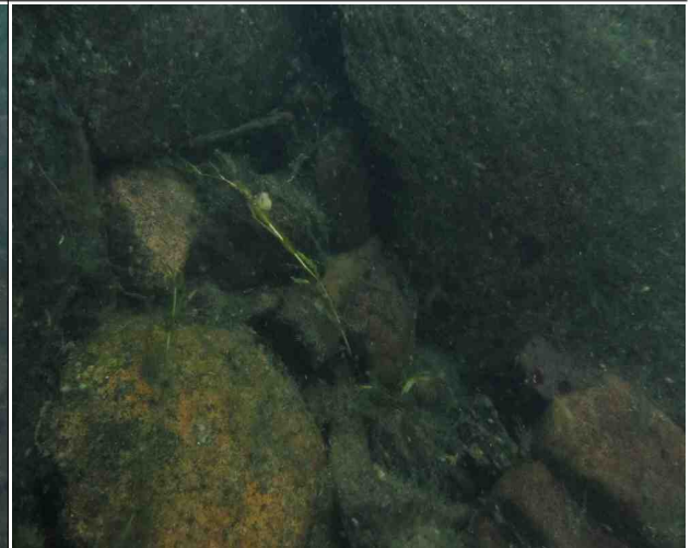
P3하행 교각 보호사석, 상태 양호
